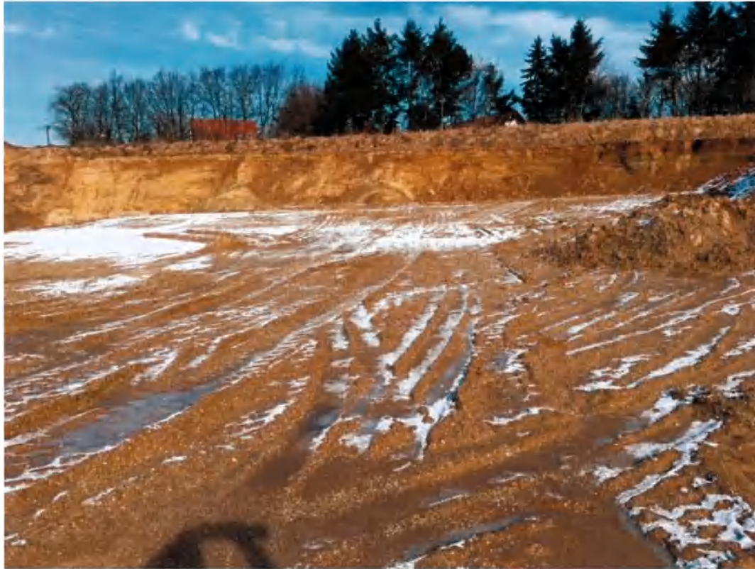
Blick auf die Abbaufäche im nördlichen Anlagenbereich. Im Bildhintergrund ist die Abbruchkante und dahinter die bestehende Bebauung zu erkennen..
