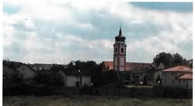
Blick nach Süden auf die Katholische Pfarrkirche Mariä Himmelfahrt
