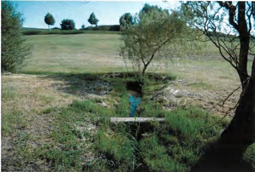
Abbildung 4: Wasser führender Graben im Geltungsbereich
